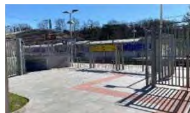
Marciapiedi e pensiline Stazione Serravalle P.se
