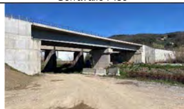
Ponte Fiume Nievole km 8+154 e Sottovia Via Marlianese
