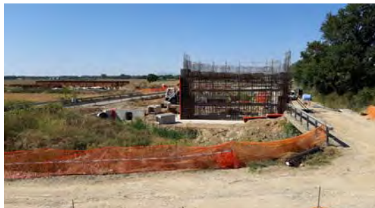
Lavori di realizzazione del nuovo ponte sul torrente Mucchia – realizzazione di una spalla
