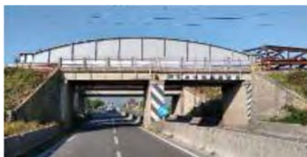
Sottovia Tangenziale Pistoia km 1+415
