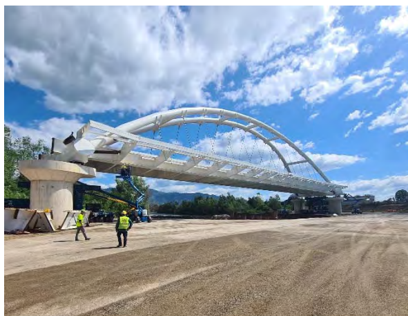
nuovo Ponte sul fiume Serchio
