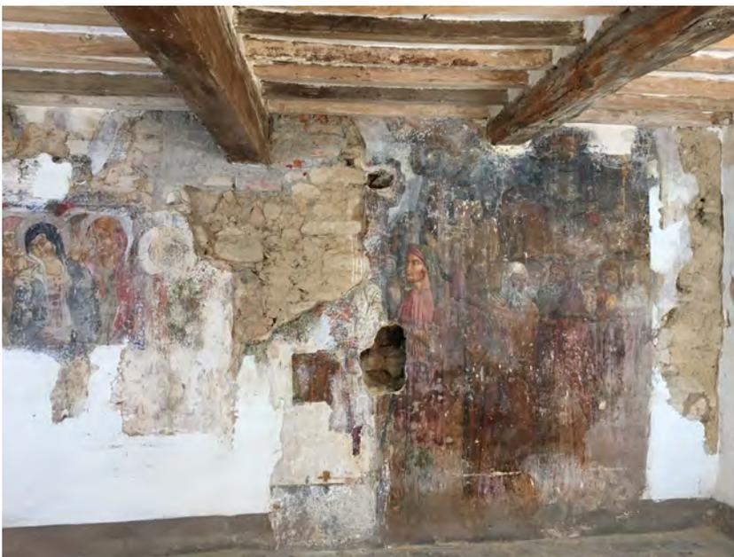
*fig.5 Murature discontinue rimosse, che hanno riportato alla luce la sede dei vecchi cambiamenti di quota delle travi dei solai*
