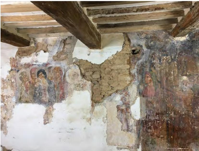
*fig.4 Discontinuità delle murature con interventi disomogenei in corrispondenza della trave centrale, probabilmente a causa di un antico crollo dell'impianto murario*
