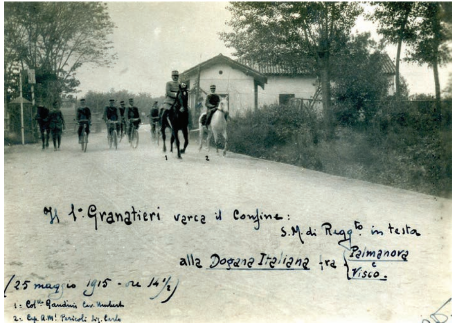
Trasferimento al fronte e attraversamento del confine italo - austriaco
