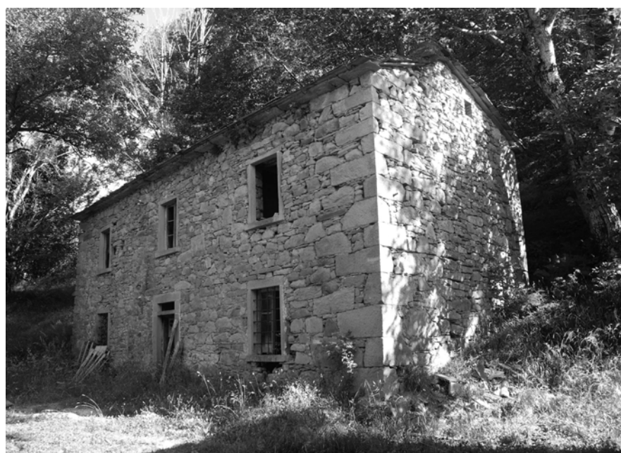
Una vecchia casa al Bicchiere di Fondo prima della ristrutturazione (Foto Leonardo Paolieri, 2006)
