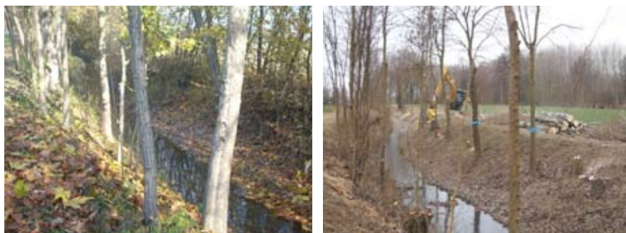
Figura 2: Piovega Annati - esempio di manutenzione a sx prima dell'intervento di fresatura a dx dopo l'intervento
