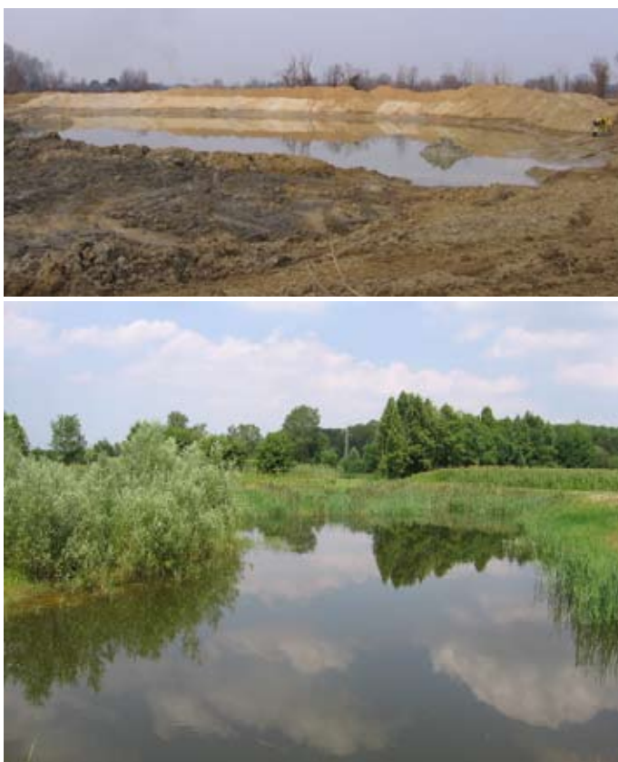
Figura 4: Riqualificazione ambientale del fiume Dese con la creazione di vasche di laminazione
