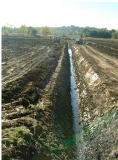
Figura 4: Fase di cantiere, preparazione del sito pilota
