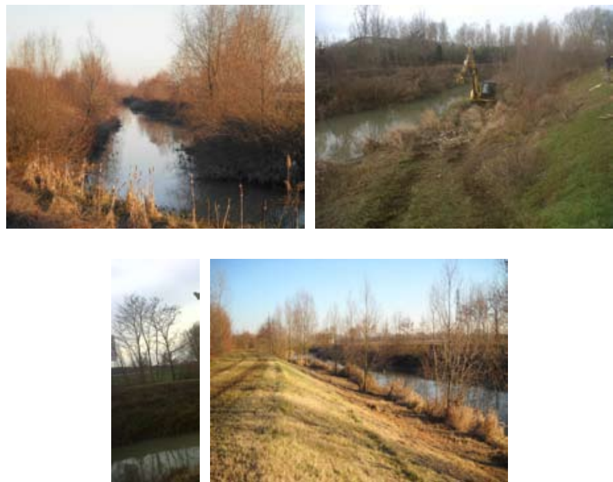
Figura 3: Esempi di manutenzione del fiume Zero. In alto a sx prima il fiume prima dell'intervento, in basso a dx il fiume dopo la manutenzione
