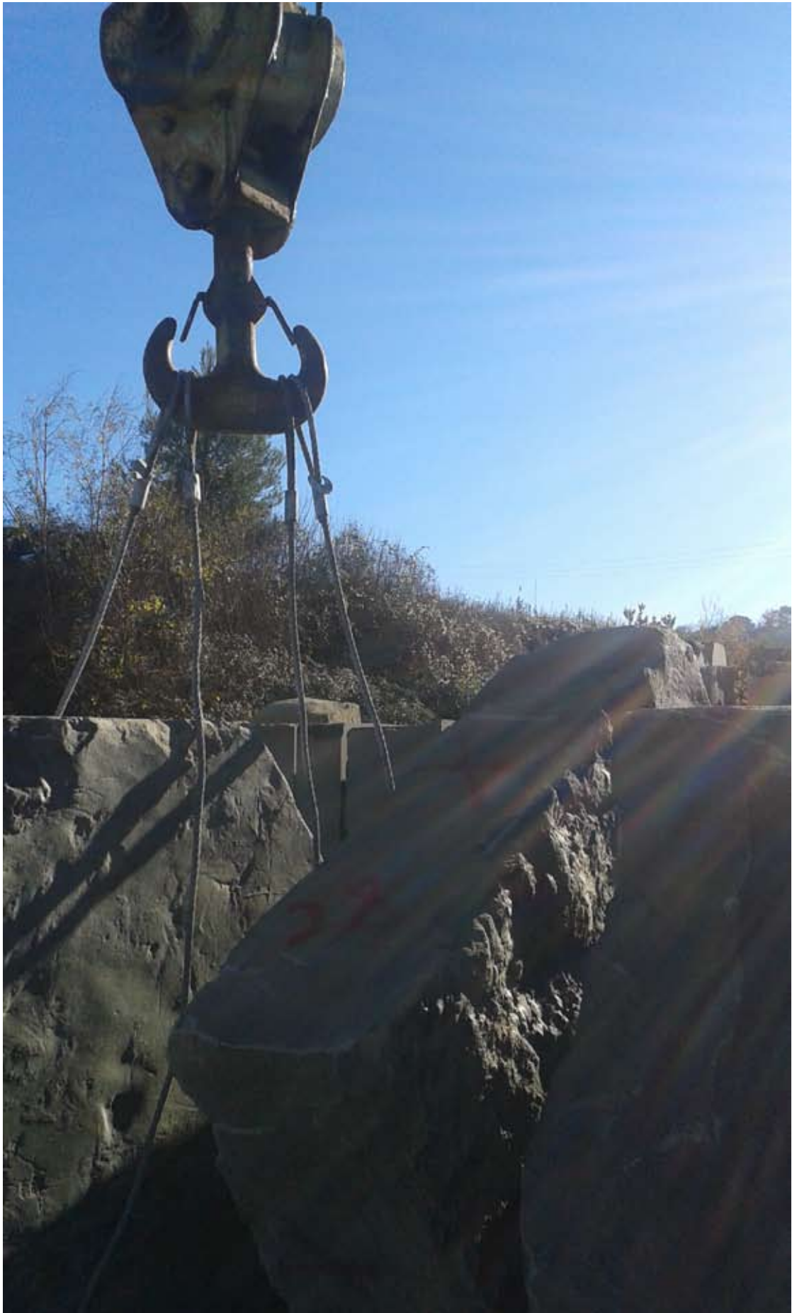
Movimentazione dei blocchi di Pietra Macigno con il carro ponte
