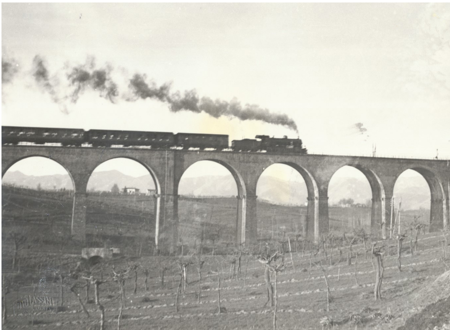
B2 - Il treno sul viadotto della tratta ferroviaria Borgo San Lorenzo- Faenza, inaugurata il 23 aprile 1893 (Archivio Aldo Giovannini)
