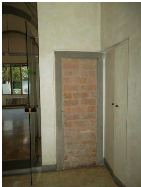
Figura 58: Porta con stipiti in pietra di accesso al vano PT 17, ambiente definito in questa fase con la funzione di vano scala per la salita al nuovo primo piano
