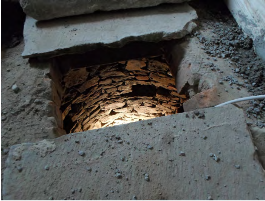
Figura 50: Pozzo collocato tra i vani PT 14 e 15 (USM 23) al momento della scoperta
