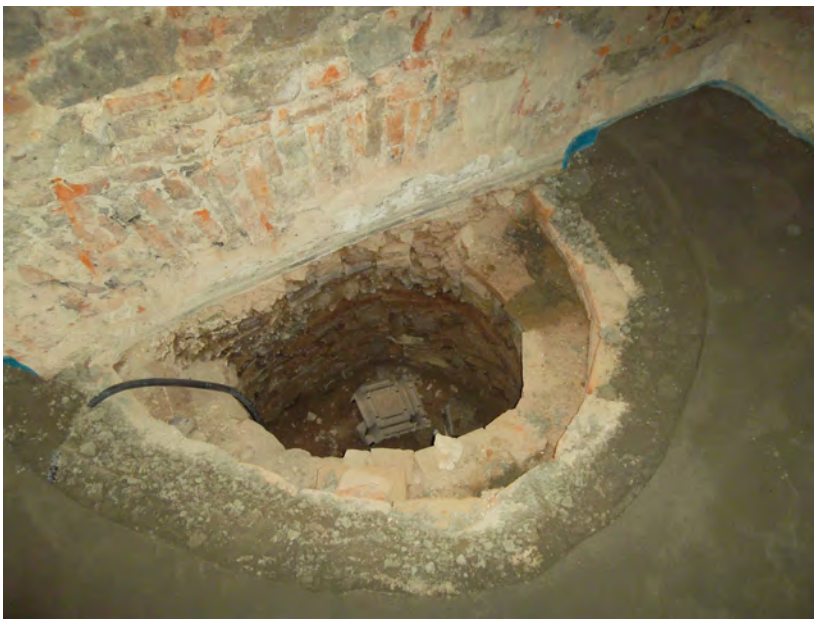
Figura 47: Bordatura di ripiano in mattoni messa in opera attorno alla bocca di un preesistente pozzo (USM 71) in piccole bozzette di pietra nel quadrante sudoccidentale di INT 24/25
