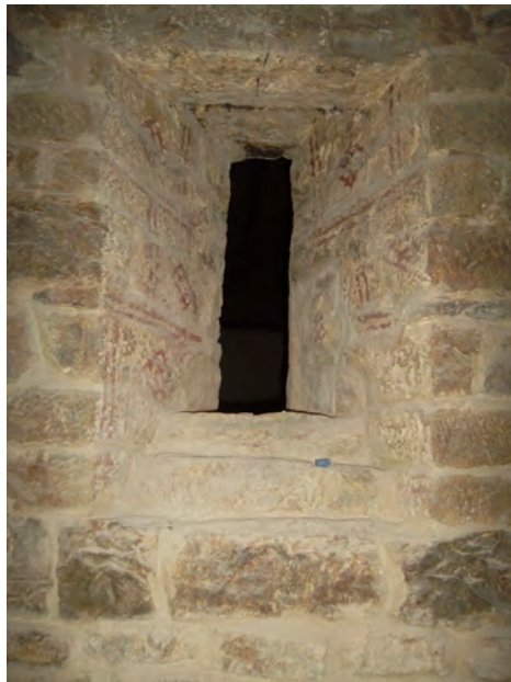
Figura 22: Nel vano PT 11, sul versante orientale, la parete est della turris , ancora in luce all'interno della Biblioteca "Pietro Leopoldo", presenta nell'elevato una feritoia strombata
