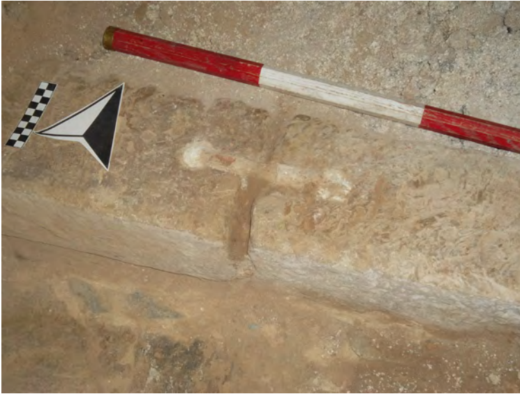
Figura 35: Riparazione della porta della turris , con l'aggiunta di una serie di grappe sulla faccia superiore del gradino
