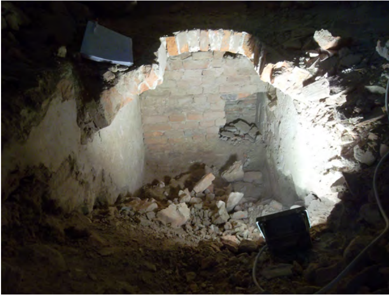
Figura 52: Primo vano scala, diretto verso lo scantinato di INT 24/25 a partire dall'interno dell'attuale vano PT 15 (USM 22 e USM 24)
