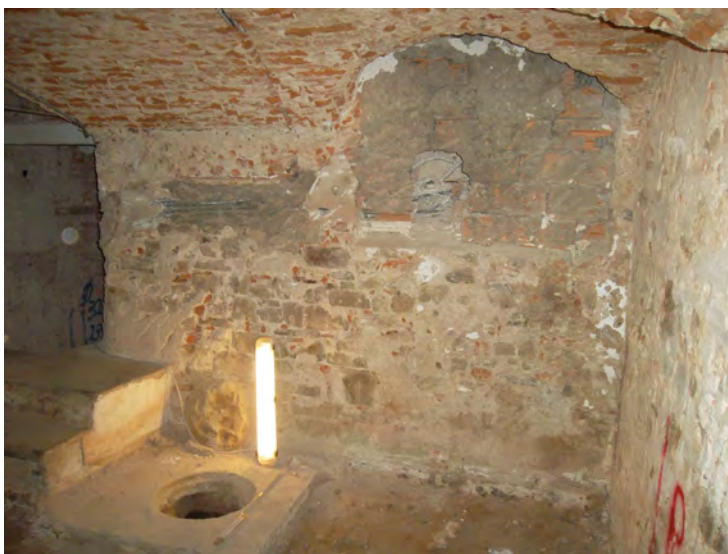
Figura 91: Il vano INT 13 ed, alla parete ovest verso la sua estremità settentrionale, la tamponatura di una finestra-abbaino con labbro spiovente verso la cantina, sguanci e sporti con battenti
