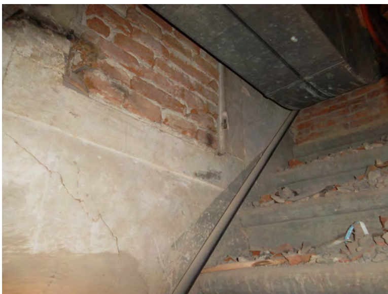
Figura 54: Finestra in seguito tamponata sul versante est dell'ambiente PT 17, di cui restano le ante laterali ed il davanzale inferiore
