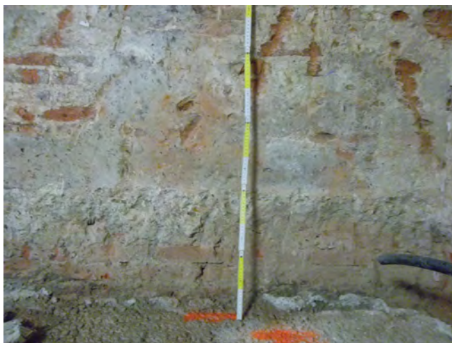
Figura 14: Piano di epoca romana, anch'esso in calcestruzzo, nella zona attualmente occupata dal vano INT 21, nella zona CENTRO dello scavo
