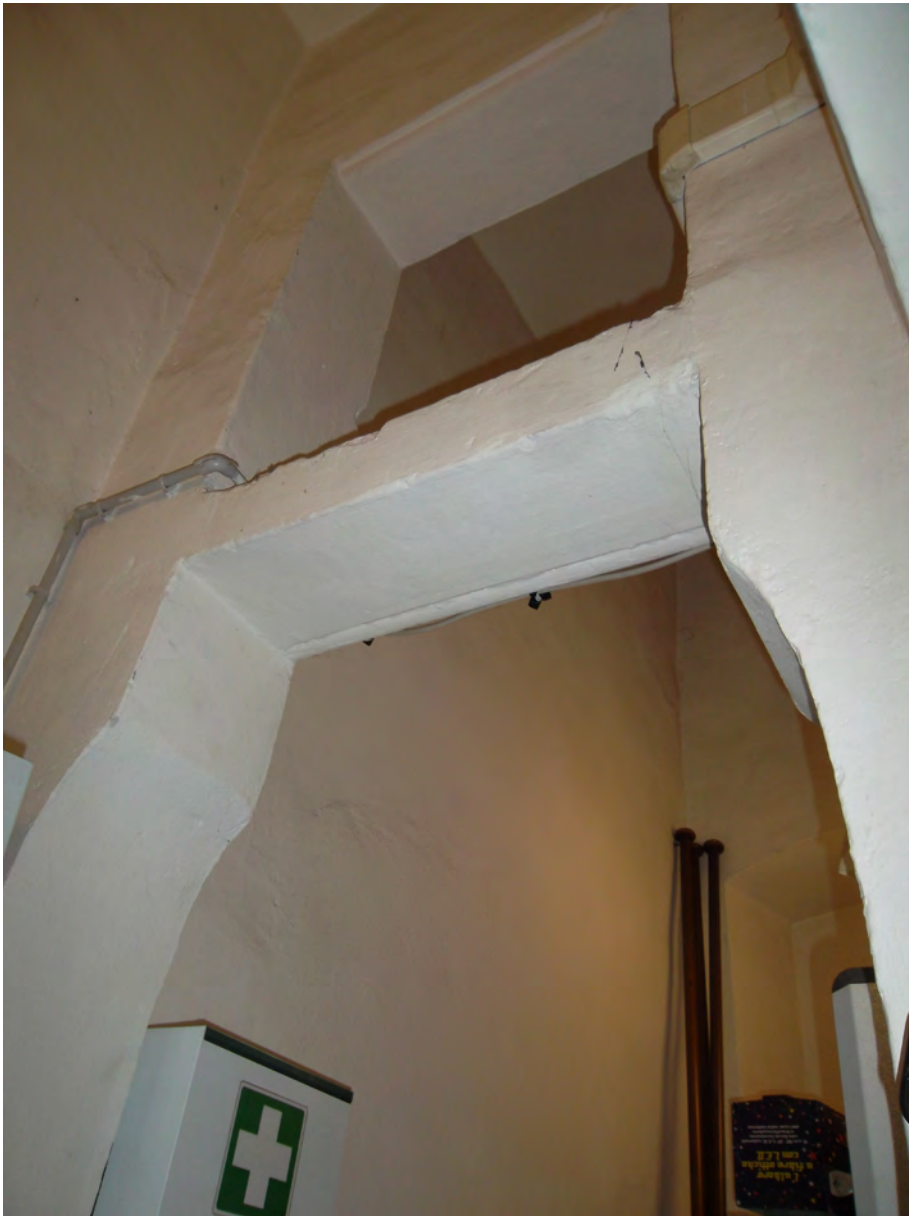
Figura 85: Portalino ad arco ad ogiva nel ripostiglio dietro la portineria attuale, sopra INT 7
