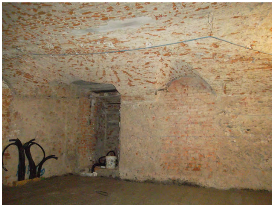
Figura 89: L'altro lato della porta, in INT 8, anche qui tamponata, corrispondente all'unghiatura nella volta
