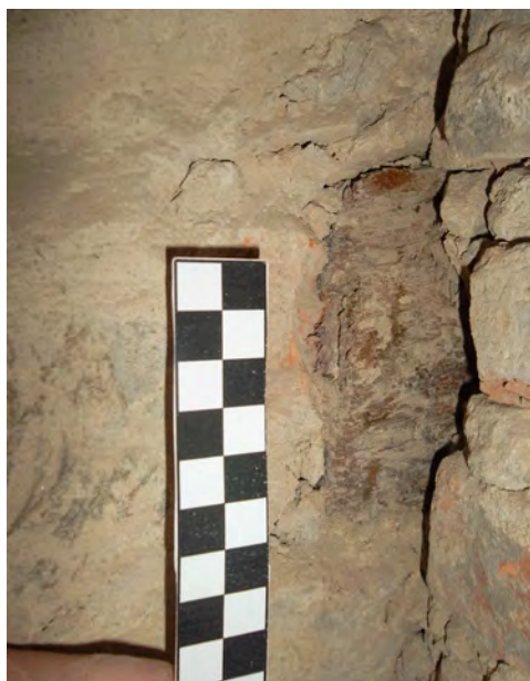
Figura 24: Presso l'angolo sud est del vano PT 11, ancora nella parete orientale, resta traccia di un architrave ligneo relativo ad una postierla
