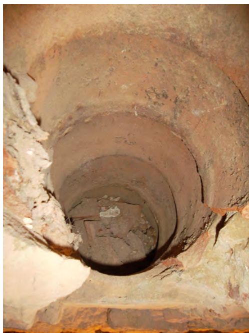
Figura 99: L'interno nel vano INT 7 di una delle tubazioni di scarico dei liquami dal gabinetto di servizio creato nel 1748 (corrispondente al vano PT 5 soprastante il vano INT 7), tubazione diretta all'orcio della Figura 96
