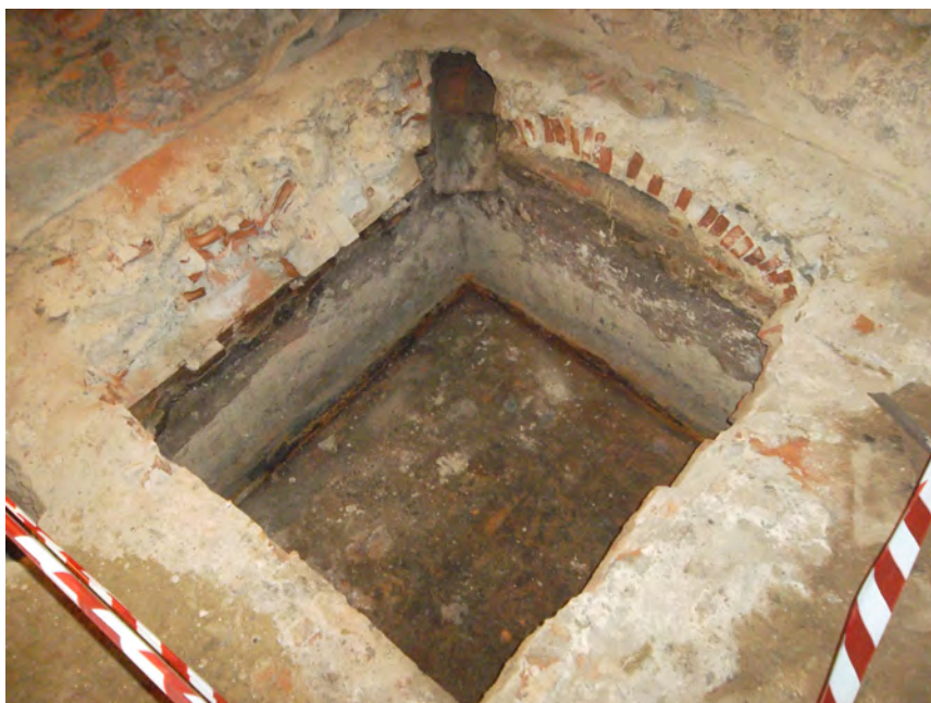
Figura 72: Ambiente sotterraneo subrettangolare con copertura a volta a botte in mattoni (USM 74) creato in questa Fase 17 EST nel vano INT 23
