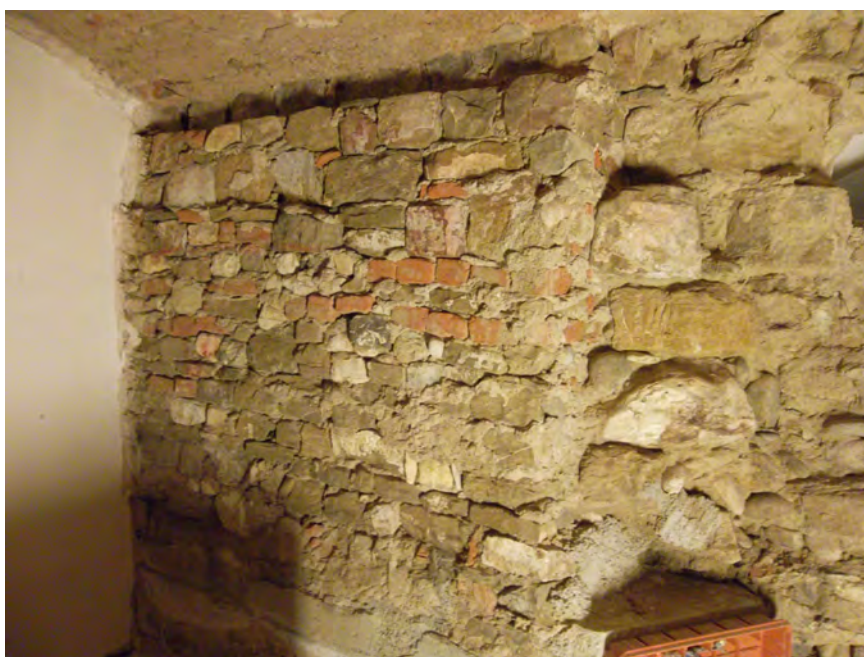
Figura 39: Nuova muratura parallela USM 78 eretta sotto PT 27
