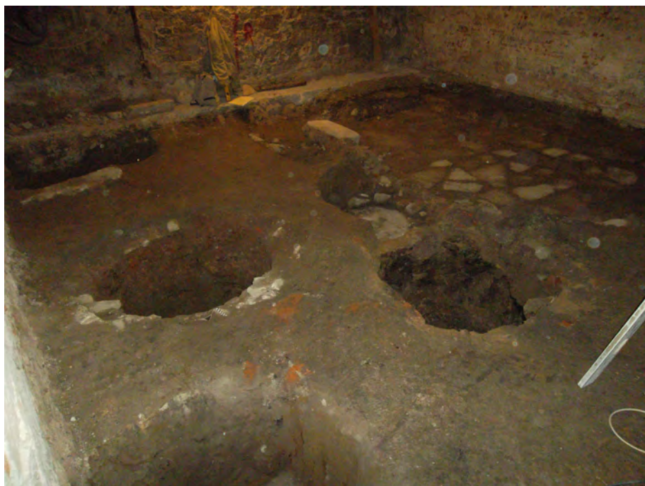
Figura 77: I due più ampi pozzi circolari del vano INT 5, ovvero quello settentrionale e quello nordorientale
