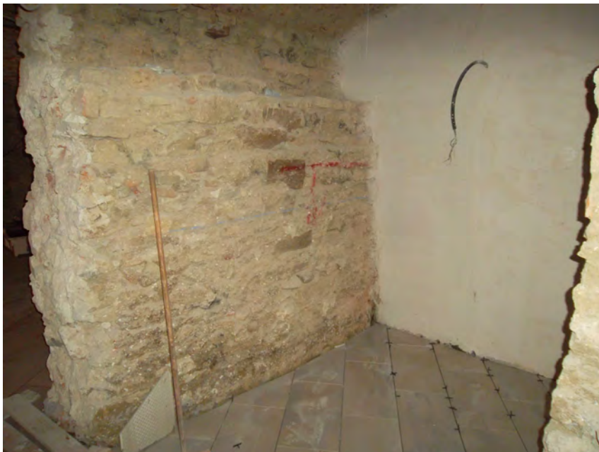
Figura 38: Muro USM 77 tra lo spazio sotto PT 27 e INT 24/25, accuratamente rasato al suolo in questa fase
