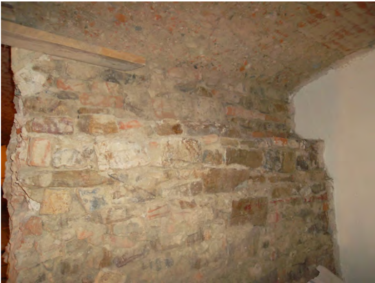
Figura 31: Muraglia che forma, in allineamento, le pareti orientali dei vani INT 24/25 e INT 2/3
