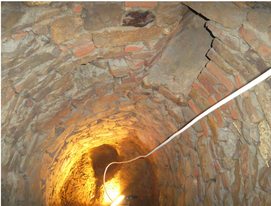
Figura 51: Interno del pozzo collocato tra i vani PT 14 e 15 (USM 23)
