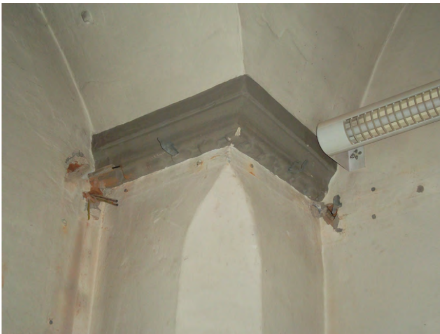
Figura 65: Pilastro ottagonale sguanciato con capitello dentellato nella loggia angolare di PT 14 eretta in questa fase
