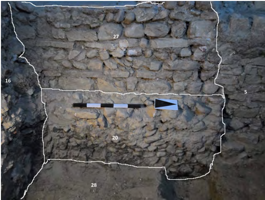
Figura 40: Fuori dalla turris verso nord est, nella stanza PT 16, viene posato sul versante ovest del vano odierno un muro in ciottoli e pietrame di pezzatura piccola a filari orizzontali alternati (USM 27)
