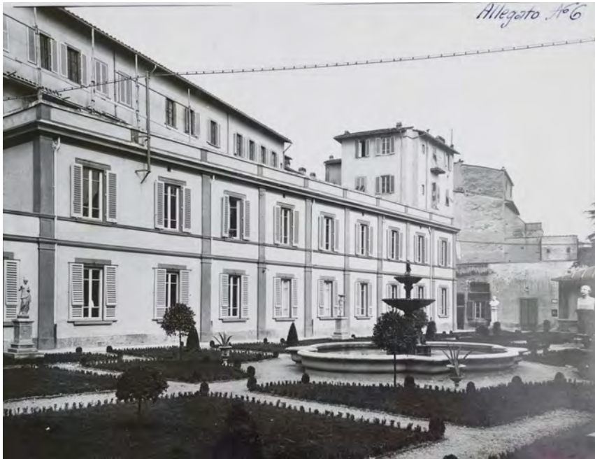
3. Fotografia anni '30, ASFi, Nello Baroni, Disegni di Nello Baroni, 47, Allegato n. 6, Sezione Speciale Lavori di Firenze, Fabbricato interno nel giardino del Palazzo Cerretani
