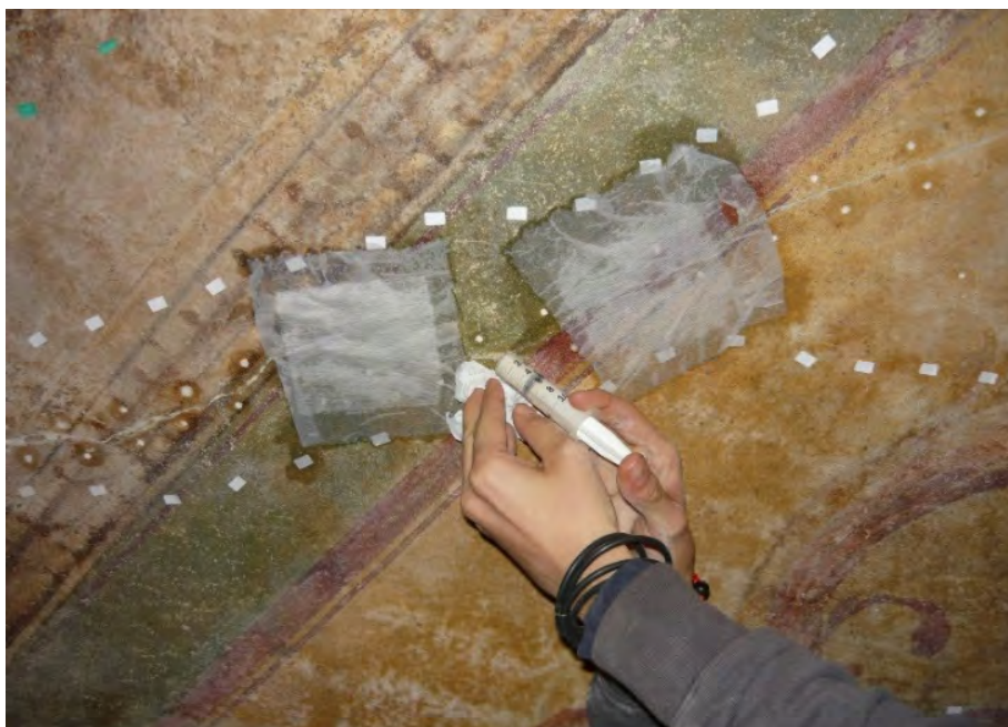
Foto 13 – Consolidamento dell'intonaco con iniezioni di resine acriliche
