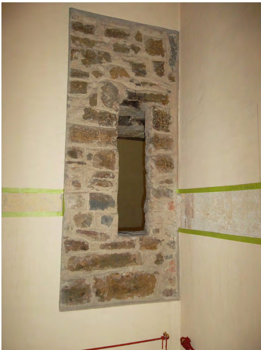
Figura 20: L'esterno della turris duecentesca sul suo lato orientale
