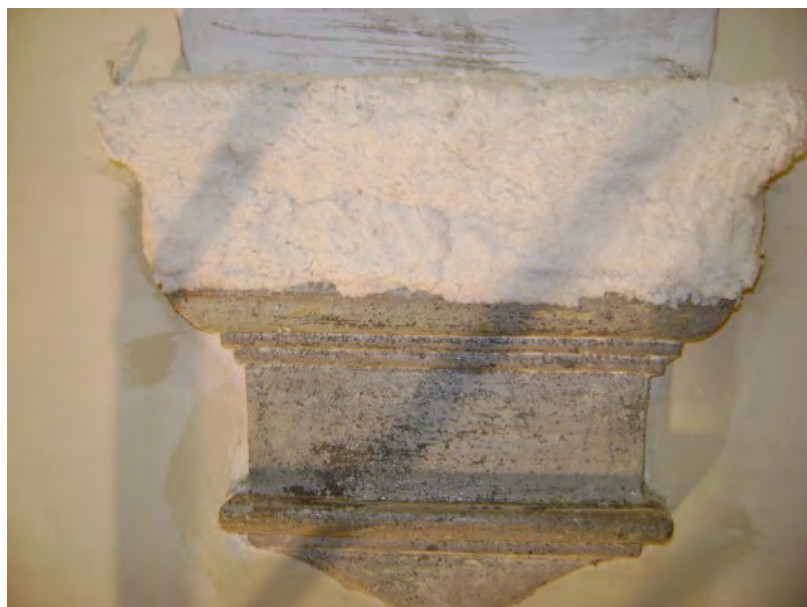
Foto 36 – Impacchi con polpa di cellulosa
