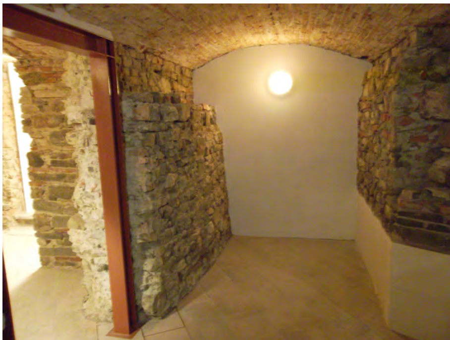
Figura 24: Le fondazioni dei due edifici ad oriente della turris , di cui quello a sinistra venne rasato al suolo per costruire quello a destra
