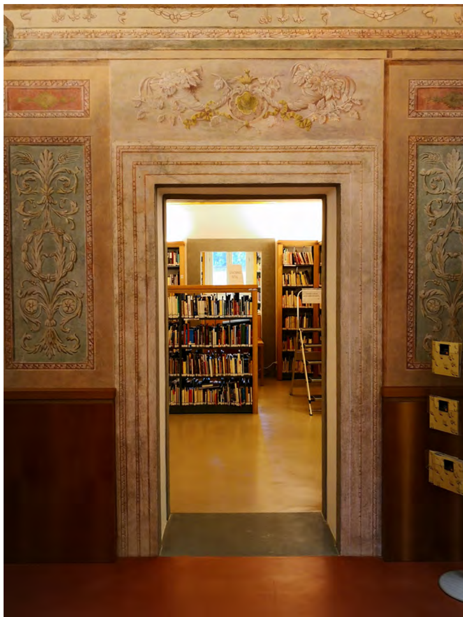
Foto 29 – Portale a lavori conclusi
