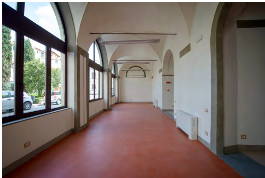
16- La loggia del piano terra verso il giardino. La percezione è oggi alterata dal tamponamento effettuato in passato delle parti inferiori delle arcate e delle aperture di testata
