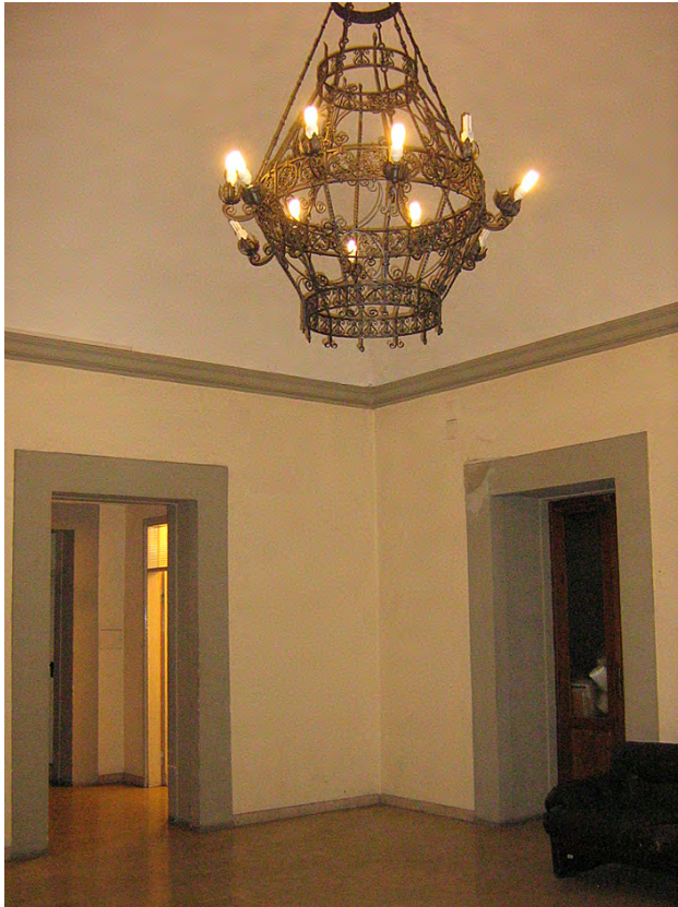
Foto 10 – Sala delle Virtù prima del restauro
