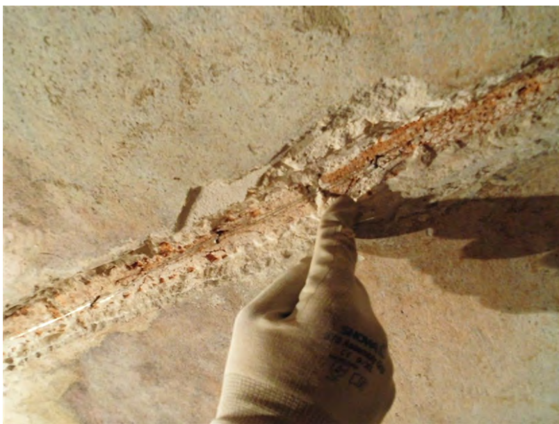
Foto 18 – Inserimento di chiodi, perni e filo di acciaio inox
