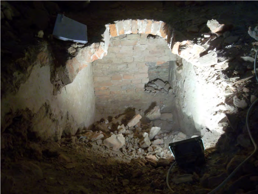
Figura 34: L'originario ingresso dalla loggia allo scantinato retrostante
