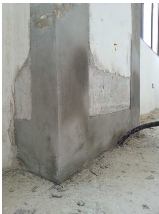
Foto 37 – Ricostruzione di lacune nei pilastri
