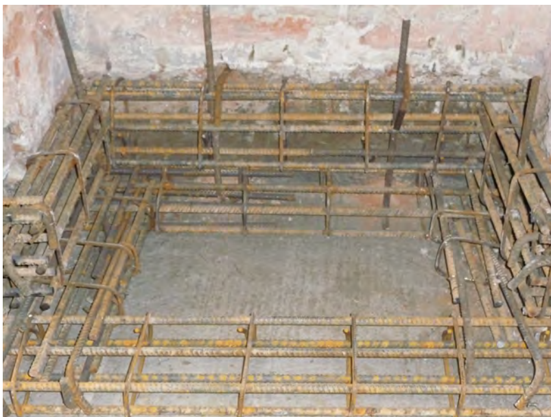
Foto 6 – Rinforzo fondazione mediante cordolatura in c.a.
