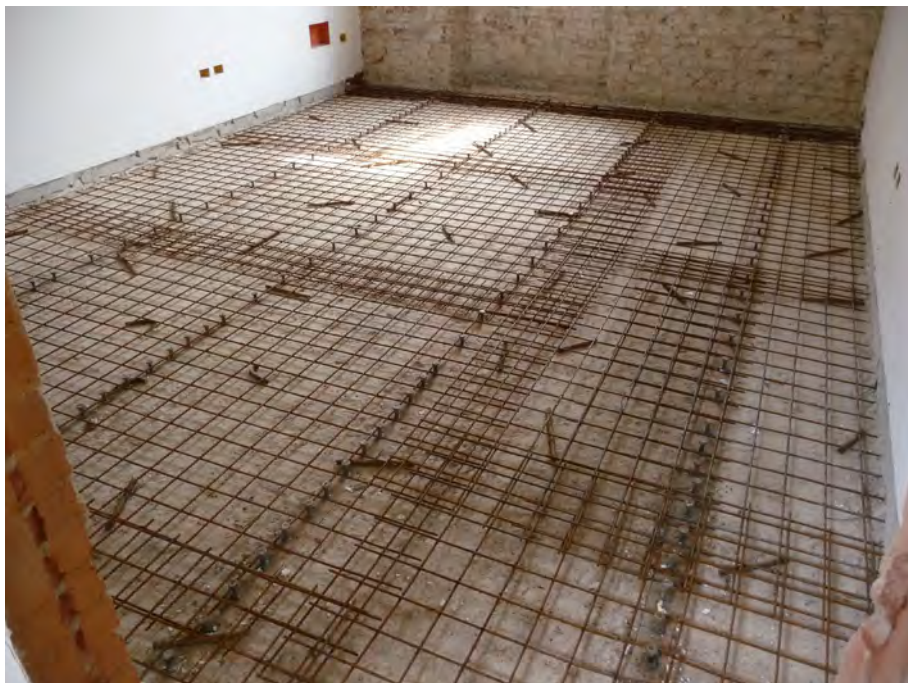
Foto 5 – Rinforzo solai esistenti con connettori metallici
