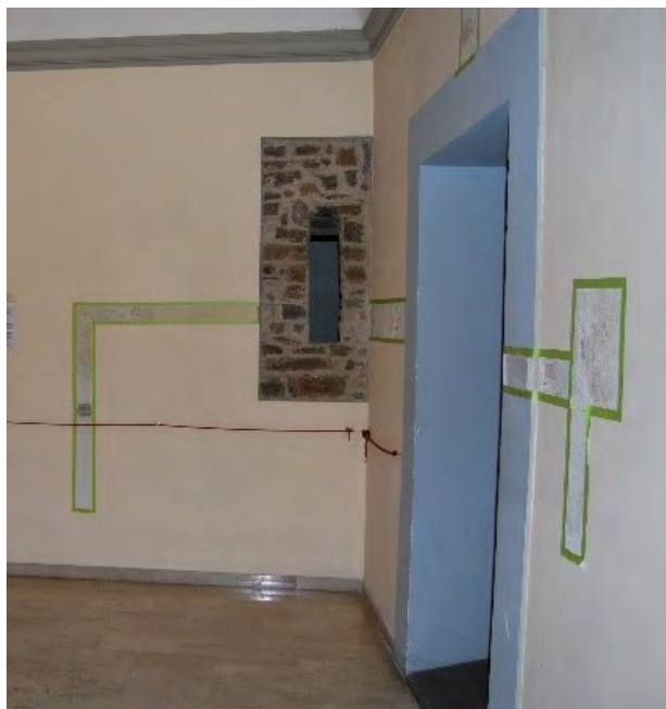
Foto 9 – Saggi propedeutici al restauro pittorico
