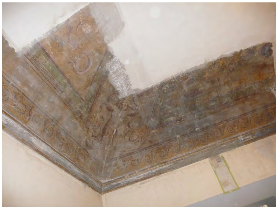
Foto 11 – Descialbo effettuato sulla volta
