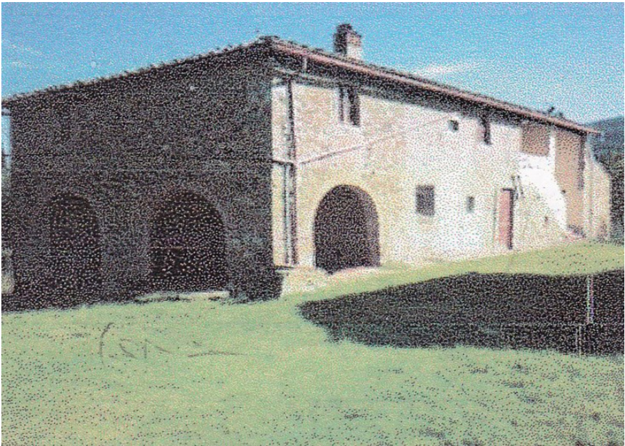
Foto 20: Casa Piagnettola dove visse Santi (9/I) (p. 10 su Mappa 39) (foto N. Fantechi)
