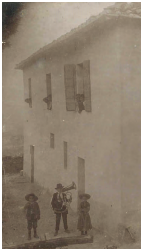
Foto 31 Inaugurazione di Casa Nanni, 1910
