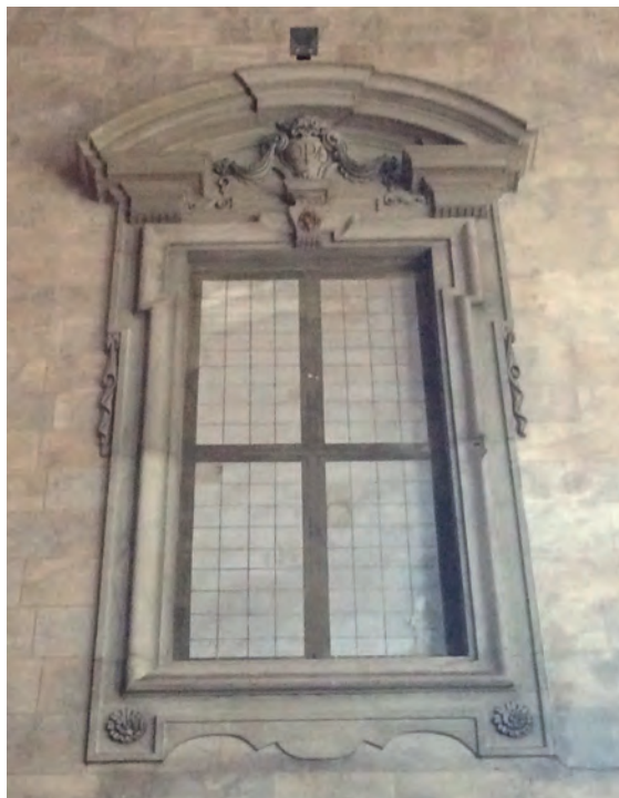
21 - Uno dei finestroni delle pareti, che furono costruiti nel 1757 in sostituzione delle bifore originali, delle quali solo due sono rimaste nella navata ed altre nel transetto, su progetto di Ignazio Pellegrini (foto di Franco Mariani).
