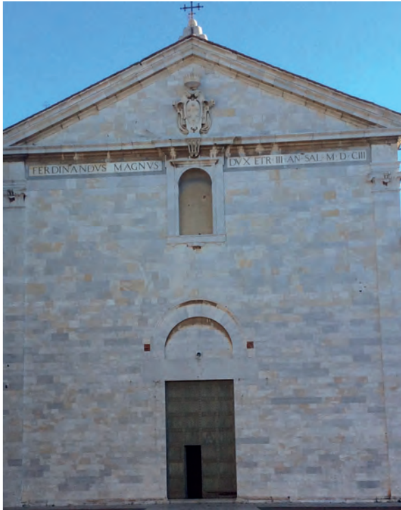
82- Facciata esterna della chiesa di San Francesco terminata nel 1603 per volontà di Ferdinando I dei Medici, come testimonia l'iscrizione posta sotto la cornice del timpano (foto di Franco Mariani).
