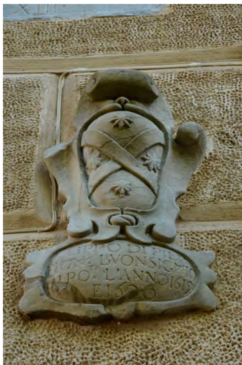
Palazzo Pretorio, facciata, stemma del Podestà Filippo di Pierfrancesco, 1619
