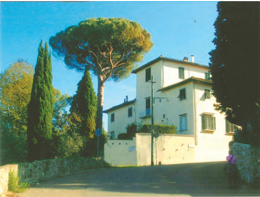
La villa Fasola vista da vicino
