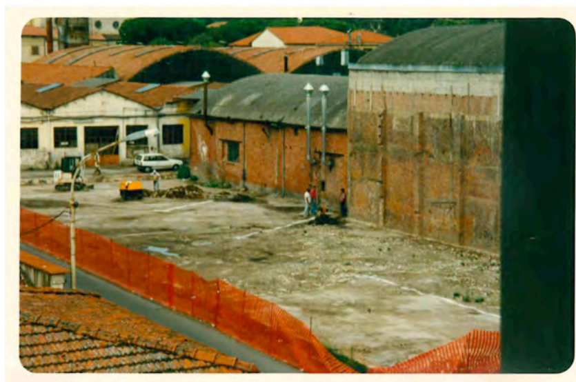
Fig. 04-XVI, Lavori di ripristino di parte dell'ex Area Lenzi lungo via Corrado da Montemagno dopo la demolizione dei capannoni bruciati. Negli anni Novanta inizia il complesso intervento di recupero dell'area industriale che ha "ricucito" il centro della città con la realizzazione di nuovi spazi pubblici: Piazza Agenore Fabbri, via Alfonso Lenzi, via European, Piazza Sandro Pertini, Piazza Enrico Berlinguer, Piazza Aldo Moro. Importanti nel tessuto urbanistico di Quarrata sono gli edifici realizzati in luogo dei vecchi capannoni dismessi, il Polo Tecnologico, la Biblioteca Multimediale Giovanni Michelucci e i nuovi complessi residenziali e commerciali. Fotografia del Comune di Quarrata degli anni Novanta
