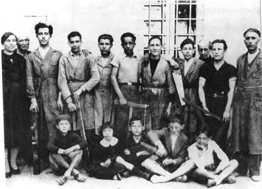
Fig. 07-III, Apprendisti della falegnameria di Renzo Frati negli anni Trenta situata lungo via Montalbano, oggi fondi commerciali. Fotografia della collezione Laura Caiani Giannini, già in "Voci dal Passato", op. cit.
