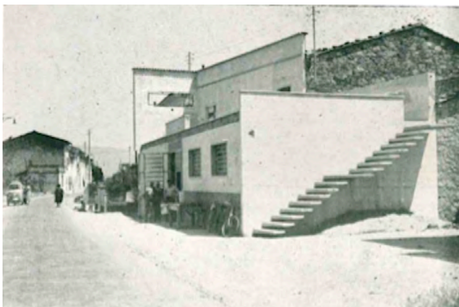
Fig. 01-XIII, La fabbrica dei fratelli Landini in una fotografia ripresa da "Quarrata e il suo Comune" del 1959 di Celio Gori Gosti. Nella fotografia si nota l'edificio già utilizzato malgrado sia "non finito", esempio assai diffuso di struttura realizzata per rispondere a necessità produttive impellenti che viene completato a seconda delle necessità della famiglia o dell'azienda
