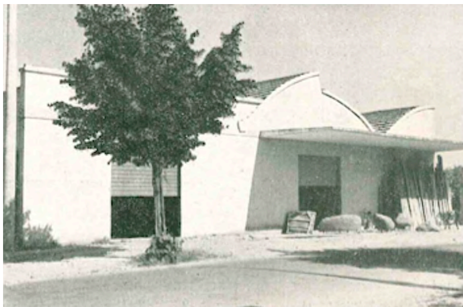
Fig. 01-XII, La sede della falegnameria di Remo Mantellassi che produceva “fusti” per altre ditte in una fotografia pubblicata da Celio Gori Gosto nel 1959 in “Quarrata e il suo Comune”
