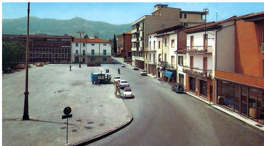
Fig. 04-VI, Piazza Risorgimento ripresa in uno scatto fotografico negli anni Settanta nella quale domina la proprietà Lenzi sullo sfondo. Nello scorcio è interessante notare che l'edificio della Dogana, ripreso nella Fig. 03-VI, è stato demolito e sostituito così come quello della Caserma dei Carabinieri della Fig. 02-VI. Fotografia collezione "Noi di Qua"
