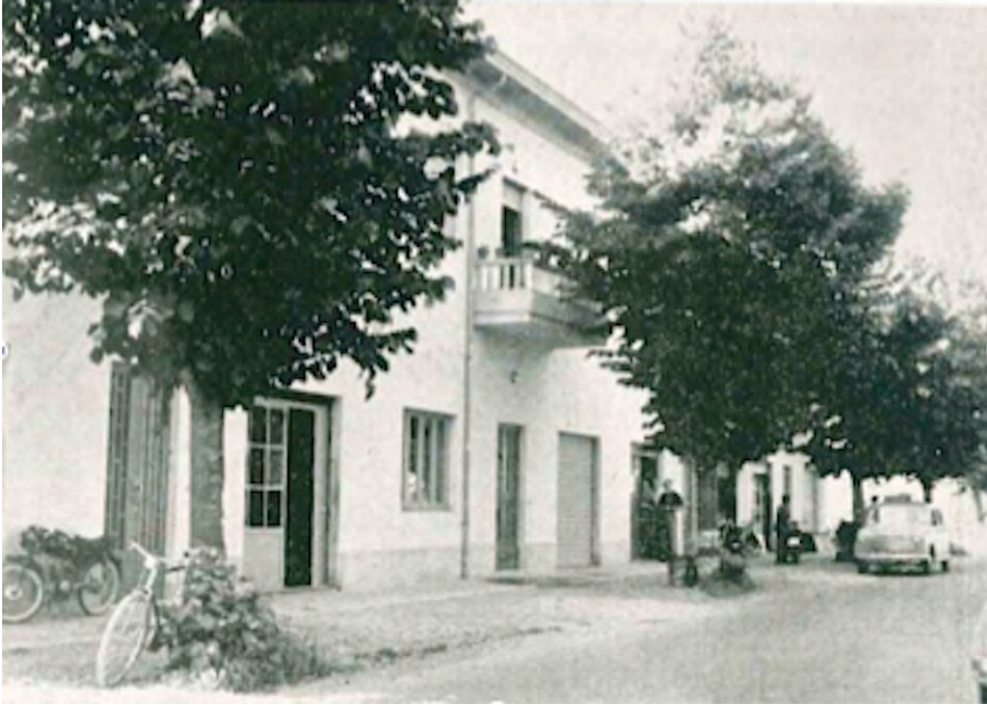
Fig. 07-II, Abitazione e laboratorio, tipologia edilizia comune nel tessuto urbano cittadino del secondo dopoguerra. Produzione, stoccaggio e residenza si concentrano nella proprietà familiare dei titolari della ditta. In questo caso è ripresa la sede della ditte Nannini, Innocenti e Venturi in via Montalbano. La fotografia del 1959, circa, è stata pubblicata da Celio Gori Gosti in "Quarrata e il suo Comune", Pistoia, Ed. Niccolai 1959 ca. L'autore specifica che tutte le fotografie pubblicate nel suo libro sono state realizzate da "Foto Convalle" di Quarrata
