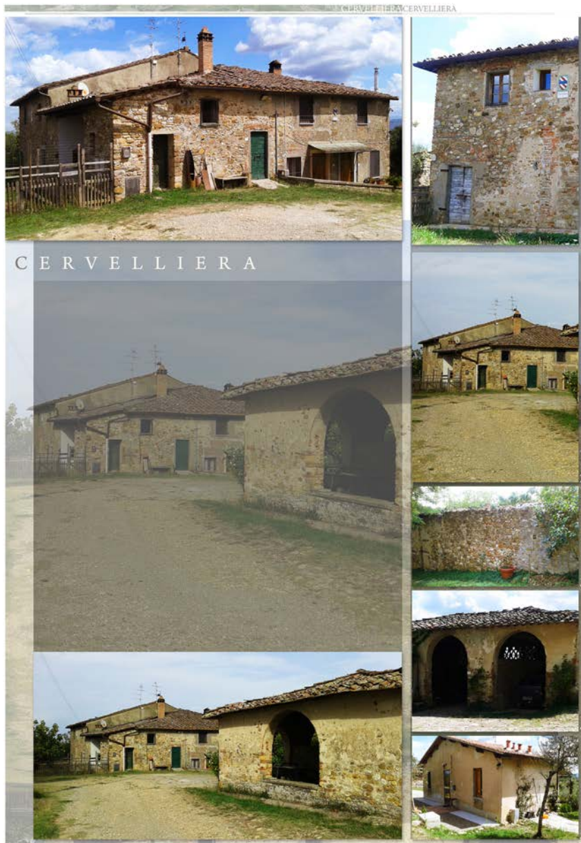
44. Raccolta fotografica degli edifici attuali
