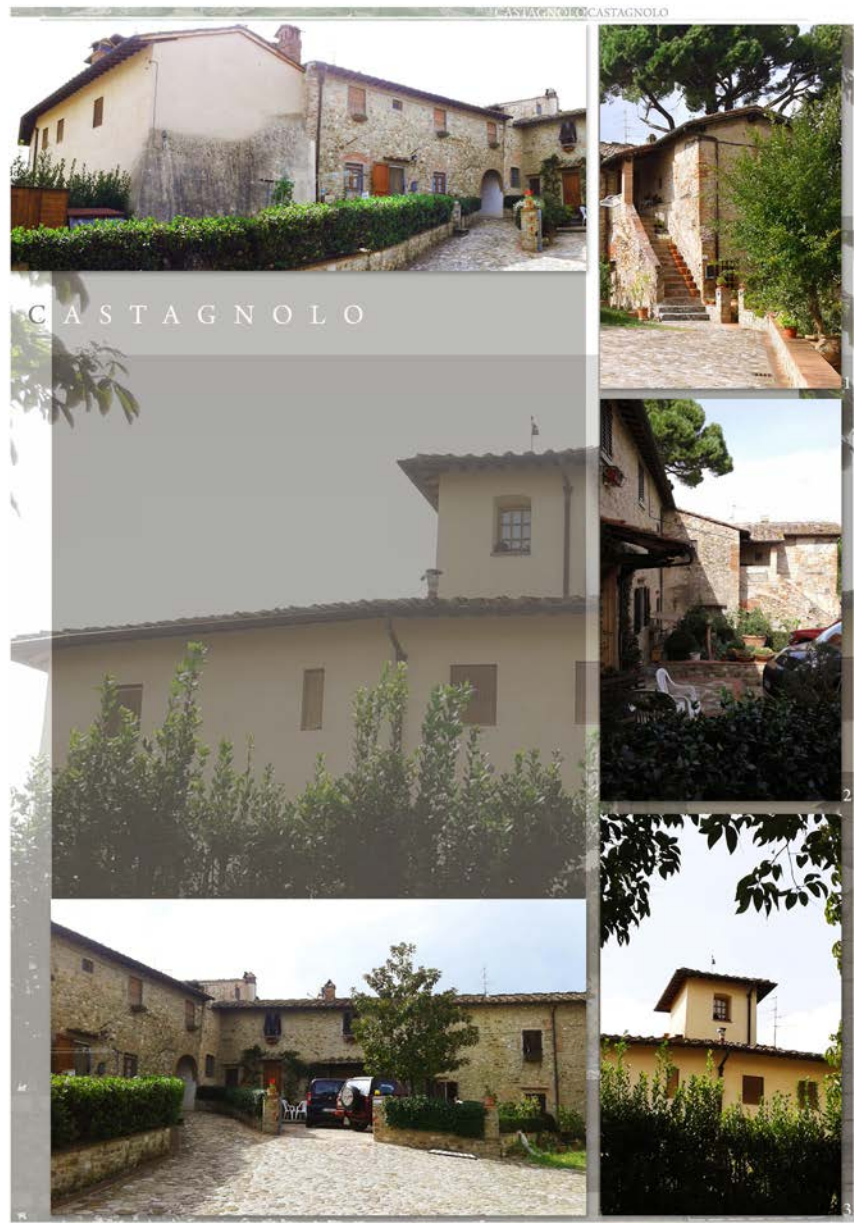
59. Raccolta fotografica degli edifici attuali
