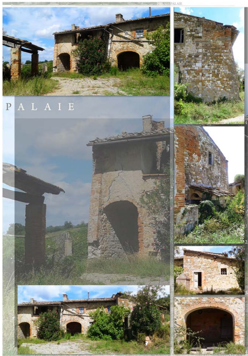
20. Raccolta fotografica degli edifici attuali
