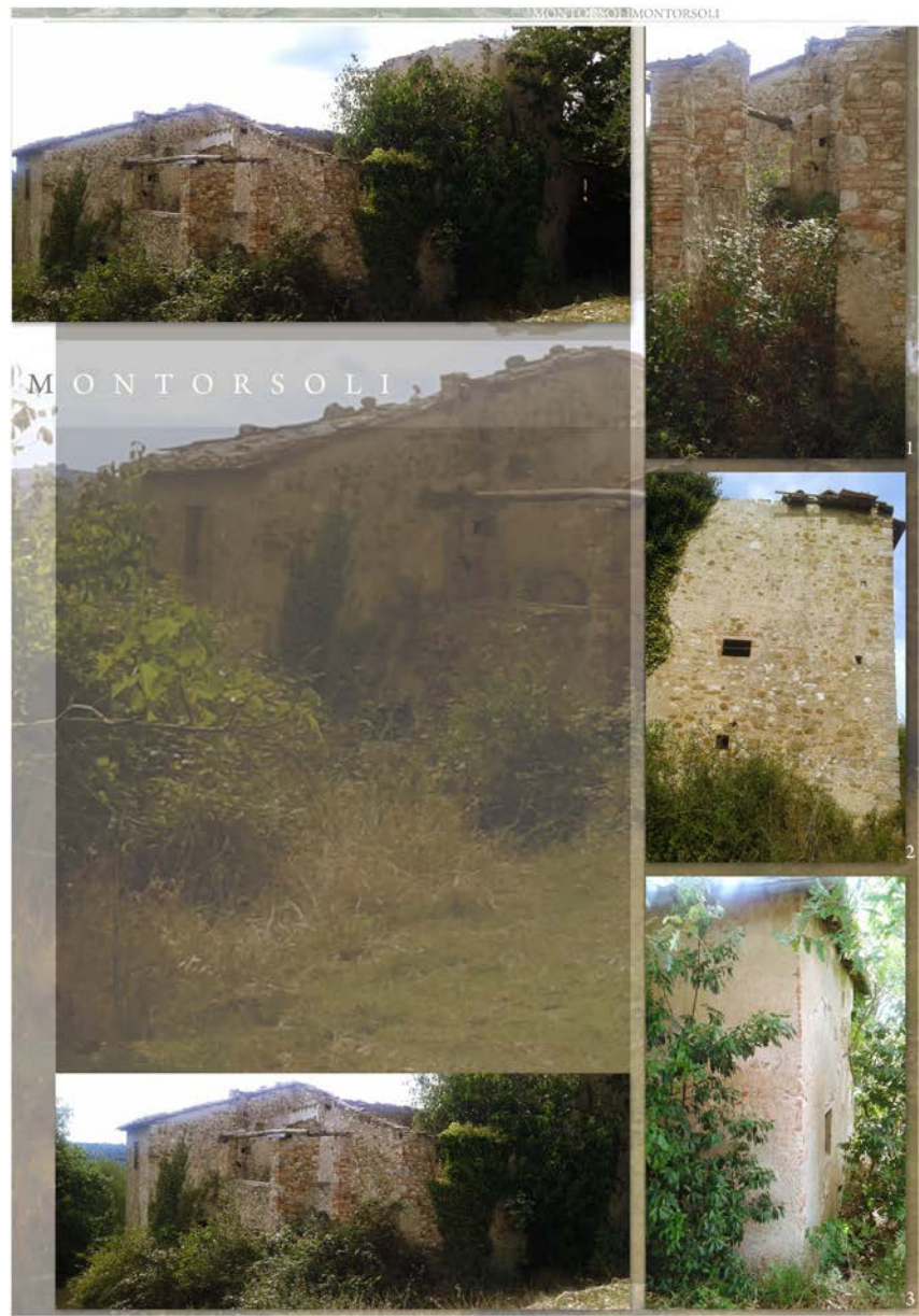
35. Raccolta fotografica degli edifici attuali
