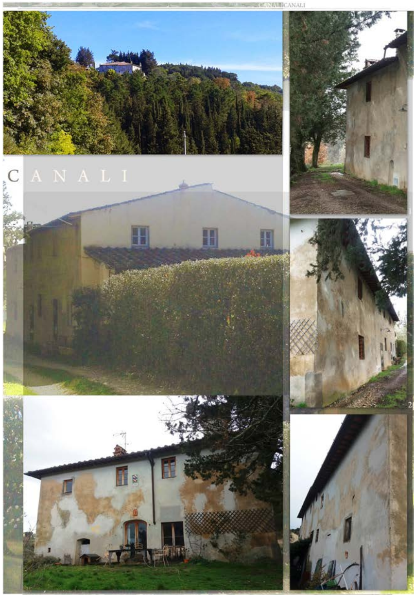
25. Raccolta fotografica degli edifici attuali
