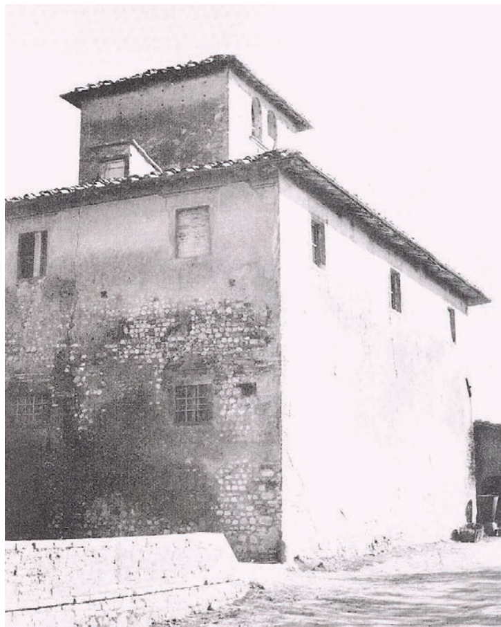
Fig. 1. Casa colonica 'La Torre', Montespertoli 3
