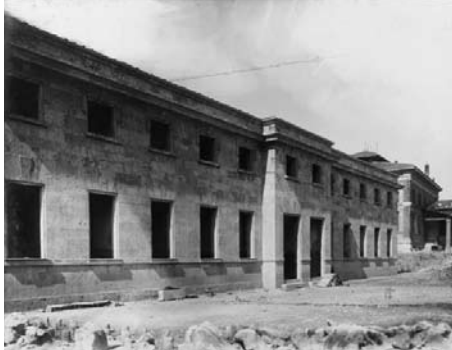
Stabilimento Leopoldine facciata tergale durante i lavori del 1930
