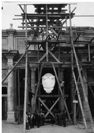
Ponteggio di fronte alla facciata per il posizionamento dello stemma
