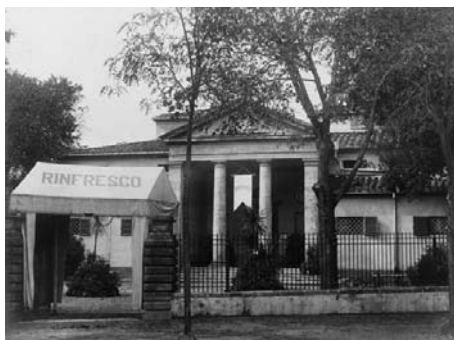
L'ingresso verso la copertura a padiglione della sorgente Rinfresco
