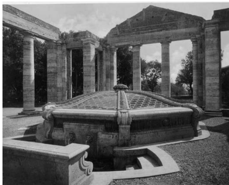
Lavori per l'edificazione del padiglione della sorgente Rinfresco all'interno del parco dello Stabilimento Torretta
