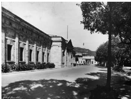
Veduta di Viale Verdi con, a sinistra, lo Stabilimento Leopoldine e sullo sfondo il Tettuccio.
