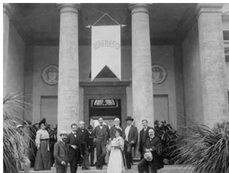
Ingresso dello Stabilimento Rinfresco
