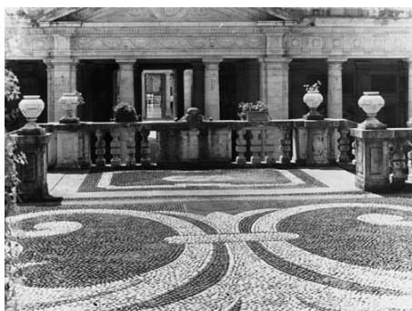
Particolare della facciata tergale dello Stabimento Tettuccio vista della terrazza
