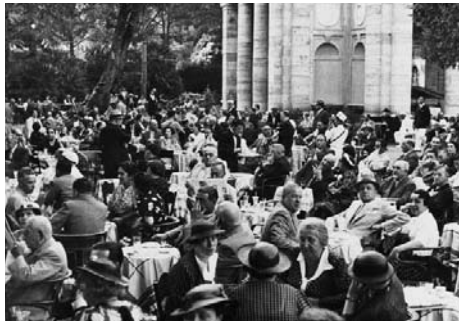
Veduta del piazzale e dell'ingresso dello Stabilimento Rinfresco
