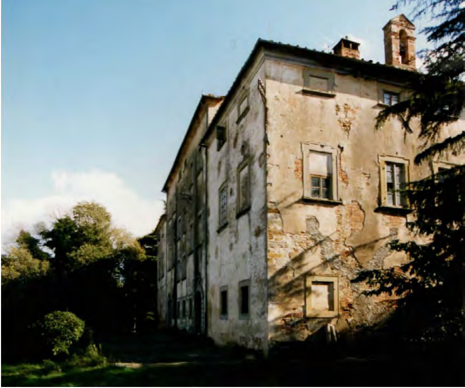
Fig. 126. Angolo nord-ovest prima dei lavori (1999) (Badia Capolona)
