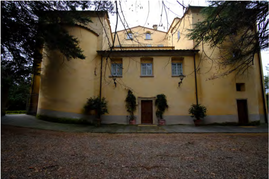
Fig. 109. Prospetto est dopo i lavori (Badia Capolona)
