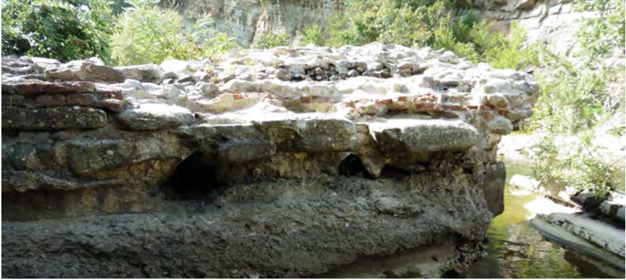
Fig. 137. Paramento, feritoie e muro di getto della pescaia del Mulinaccio (Petrognano)
