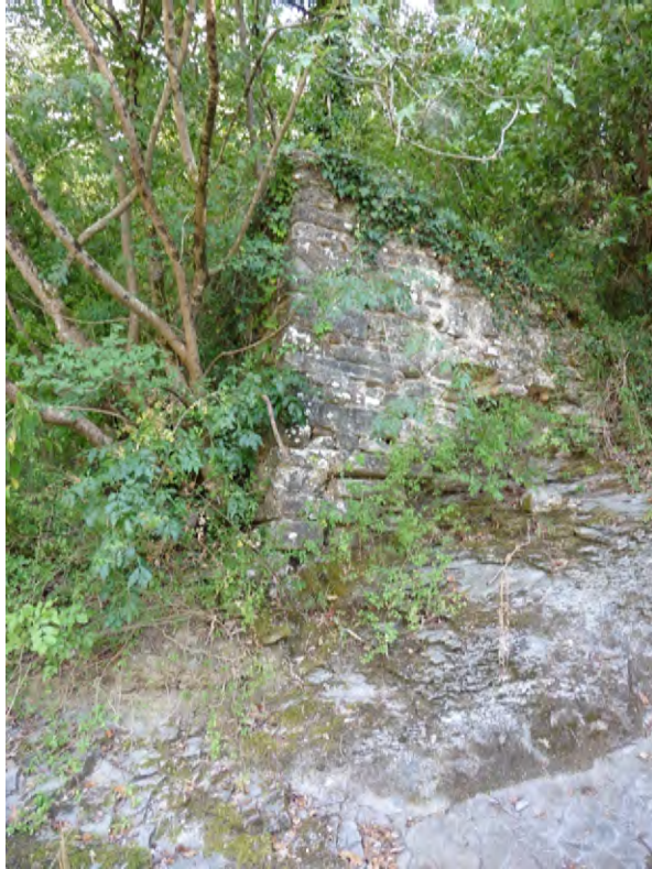
Fig. 135. Ruderi dell'edificio molitorio del Mulinaccio (Petrognano)
