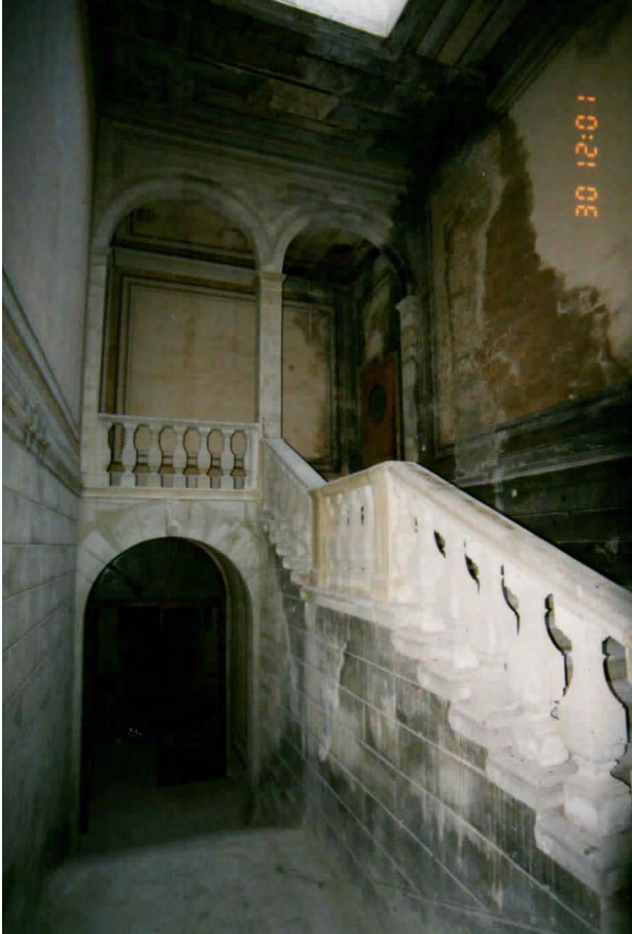
Fig. 124. Scala d'onore prima dei lavori (1999) (Badia Capolona)
