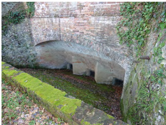
Fig. 143. Il bottaccio con le bocche d'ingresso dell'acqua del mulino di S. Margherita (Castelluccio, loc. Il Mulino; per gentile concessione di Bruna Bartoli)
