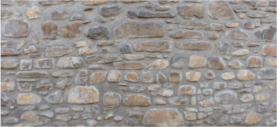
Fig. 138. Muratura a filaretto presso L'Isola (Castelluccio)
