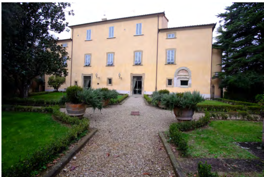
Fig. 113. Prospetto sud dopo i lavori (Badia Capolona)
