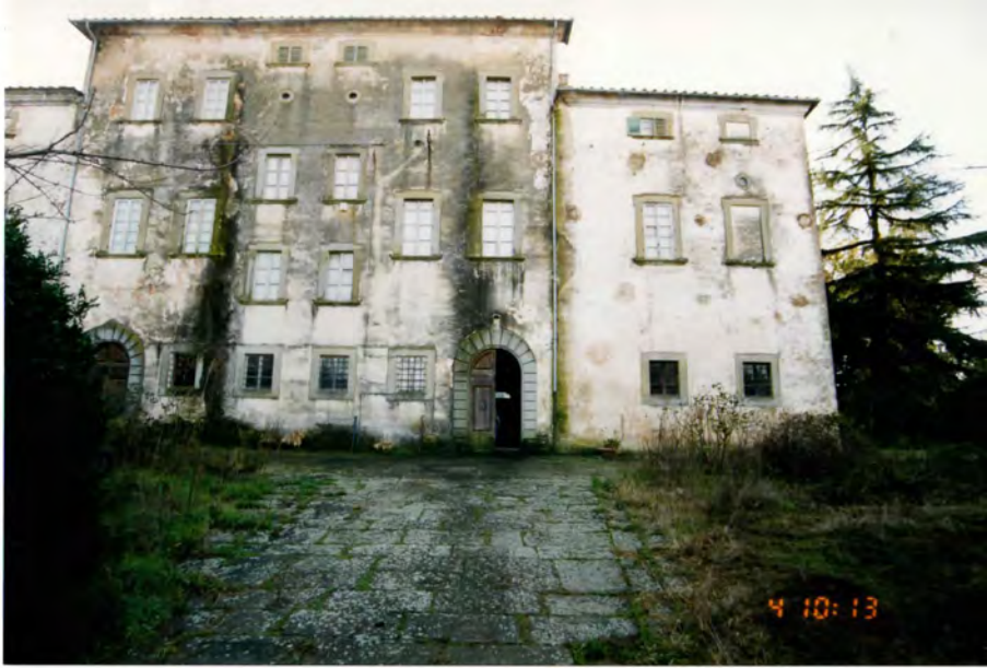
Fig. 106. Prospetto dell'ingresso prima dei lavori (1999) (Badia Capolona)
