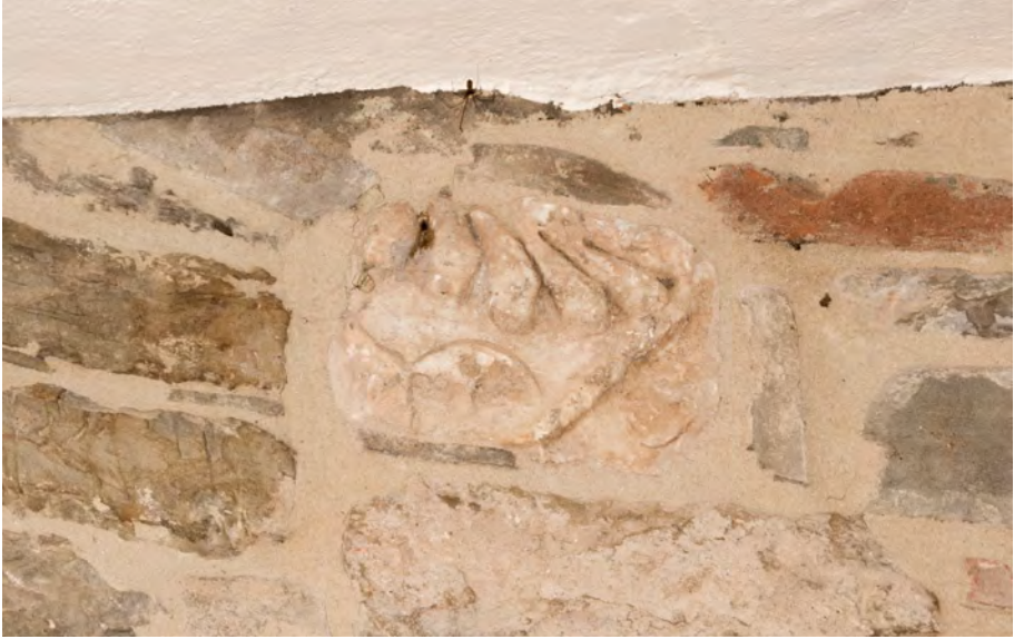
Fig. 13. Frammento antico di decorazione con motivo a palmetta: elemento di spoglio inserito nella muratura, particolare (Badia Capolona, abside di nord-est, interno)
