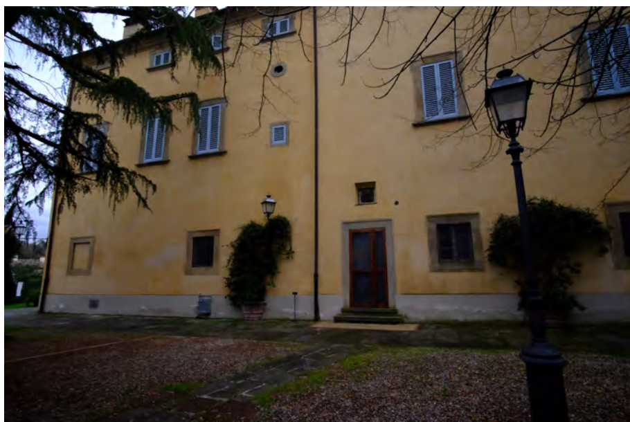
Fig. 111. Prospetto ovest dopo i lavori (Badia Capolona)
