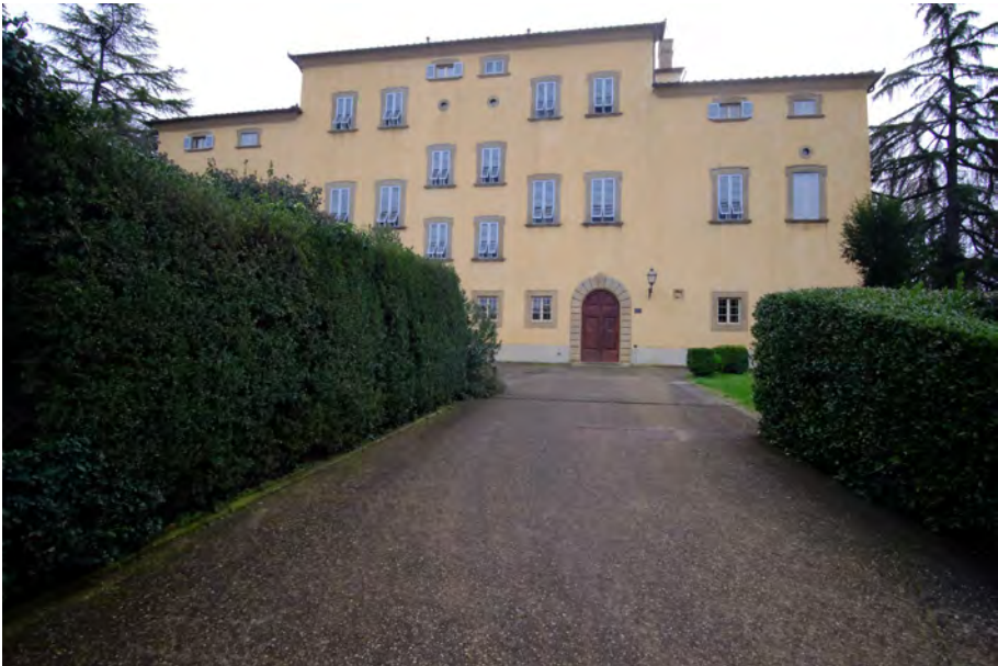
Fig. 107. Prospetto dell'ingresso dopo i lavori (Badia Capolona)
