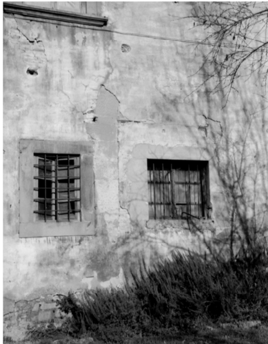
Fig. 114 b. Traccia del portale tamponato del transetto (1998) con epigrafe in vista sullo stipite destro (Badia Capolona, prospetto sud, con epigrafe in vista sullo stipite destro, particolare (Badia Capolona, prospetto sud))
