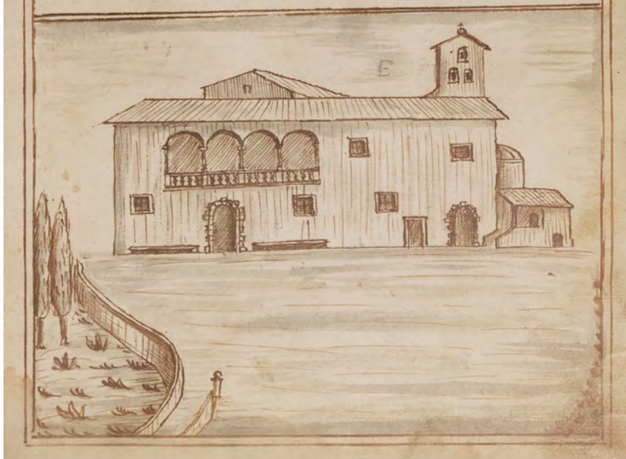
Fig. 31. Ignoto (1727), Facciata sud di Badia Capolona, copertina dell'“Inventario di tutti li Beni stabili dell'Abbazia di S. Gennaro [...]”, riproduzione fotografica da china e acquerello su carta (Collezione privata)
