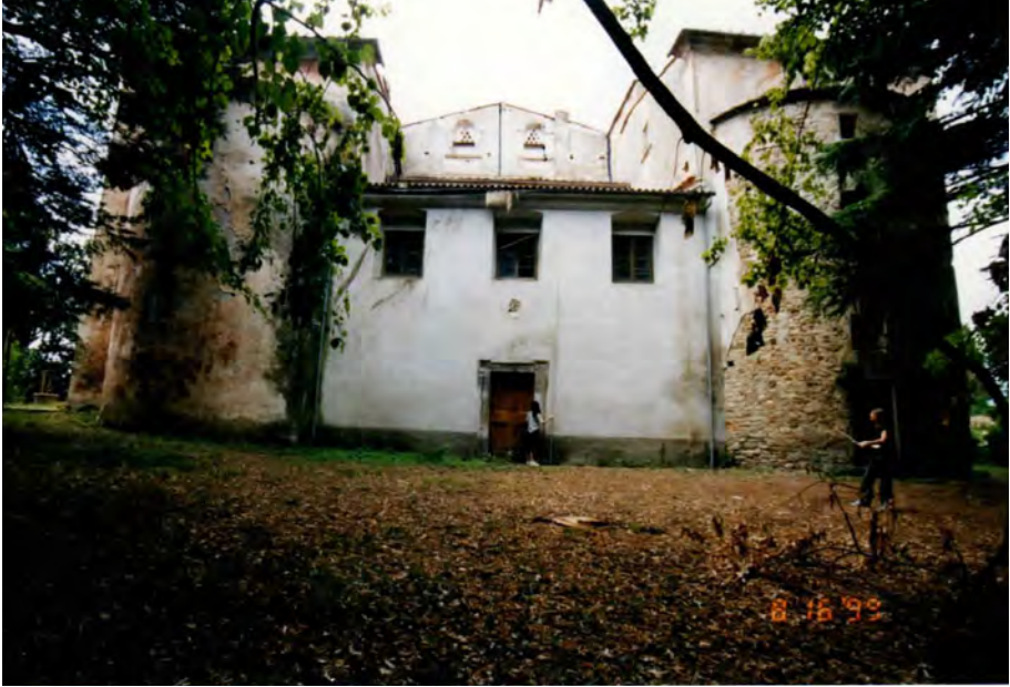
Fig. 108. Prospetto est prima dei lavori (1999) (Badia Capolona)
