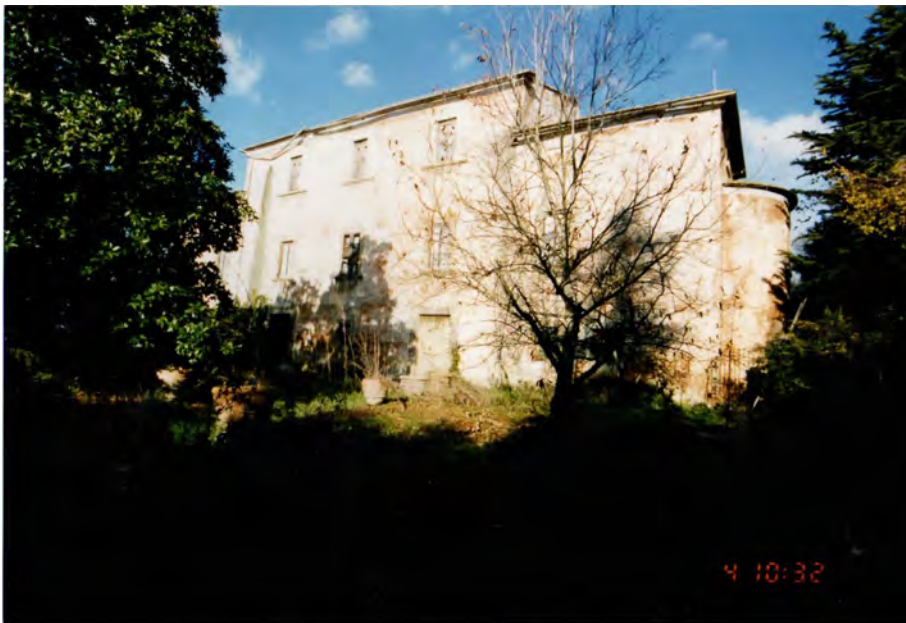
Fig. 112. Prospetto sud prima dei lavori (1999) (Badia Capolona)
