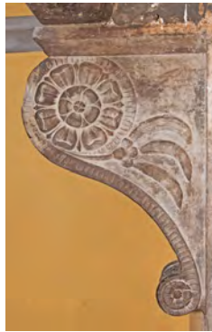
Fig. 64 a-b. Camino in pietra serena (sec. XVI), elemento di recupero: a) vista d'insieme; b) mensola, particolare (Badia Capolona, cucina)
