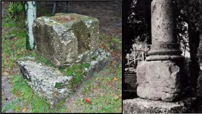
Base parallelepipedica in travertino con incassi laterali e centrale per alloggiamento di una colonna.
