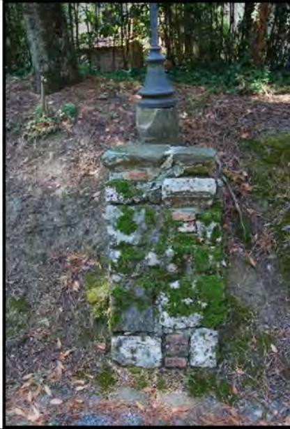
Pilastro di fioriera con elemento di trabeazione in travertino.
