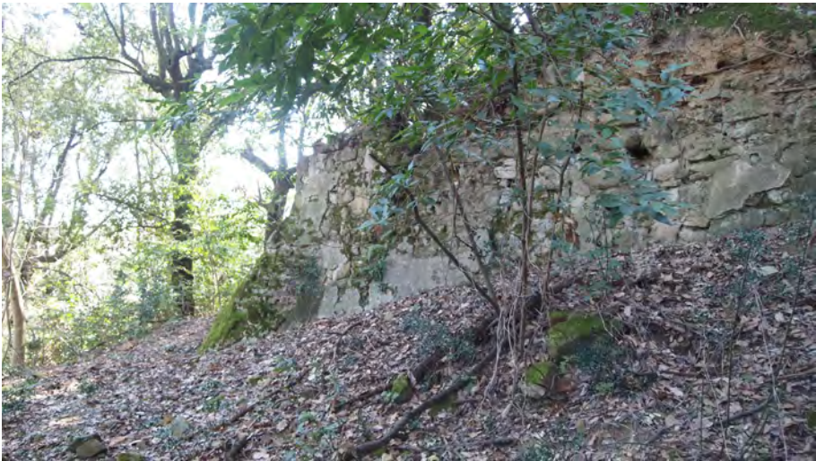
Foto n. 17 – Il muro del terrapieno dell'ucellare
