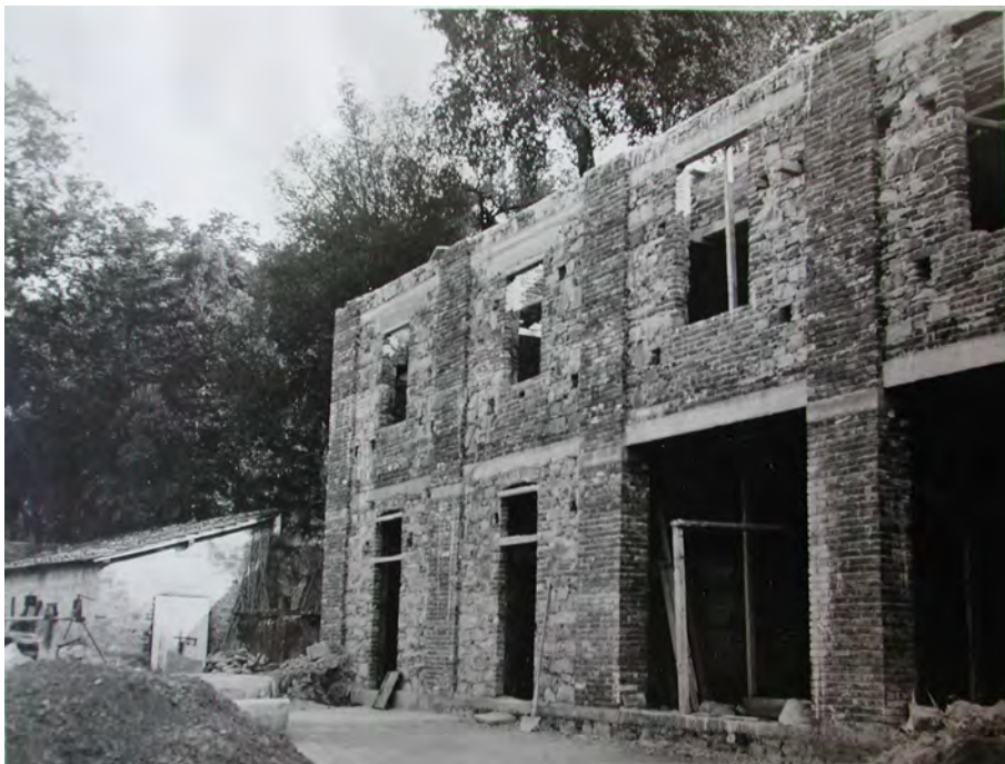
Foto n. 7 a – Ampliamento dei fabbricati del podere Le Buche a metà anni '30, archivio IAO, Firenze
