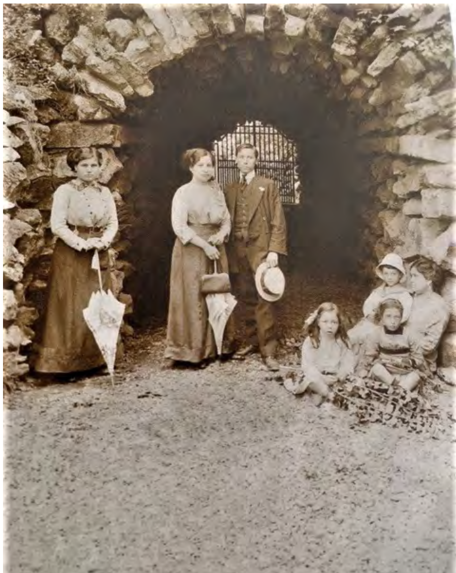
Foto n.1 – Sottopasso della Strada Regia verso il “Chiuso”, presso il Ponte del Diavolo, in continuazione del vialetto lungo la ragnaia, 1910, da “Poggio a Caiano 1879-1979”, catalogo della mostra, a cura di A. Belli, L. Corsetti, G. Desii, 2019
