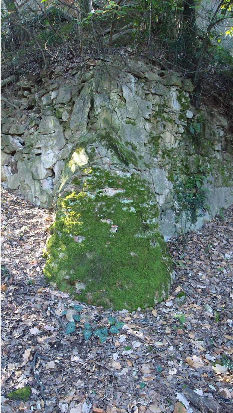
Foto n. 18 b - Contrafforte angolare del terrapieno
