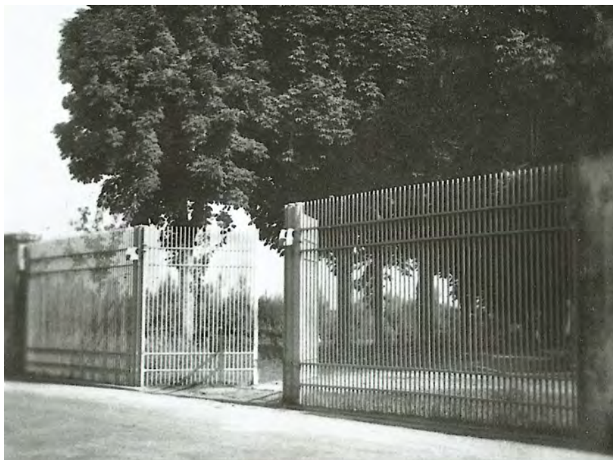
Foto n. 8 b – La cancellata di fronte alla precedente, verso il viale degli Ippocastani che conduceva al ponte Leopoldo II, collezione A. Belli
