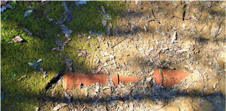
Foto n. 27 a e n. 27 b Resti di acquidocci trasversali in tubi di terracotta, messi in opera probabilmente nell'Ottocento, per lo smaltimento delle acque meteoriche a protezione dei vialetti principali
