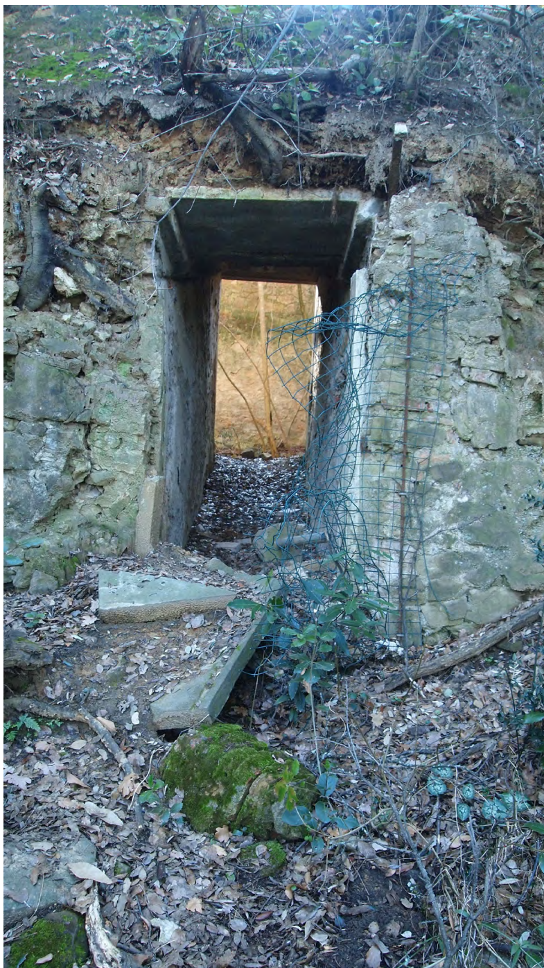
Foto n.18 a – Corridoio d'ingresso ai vani interrati del casino di appostamento dell'uccellare
