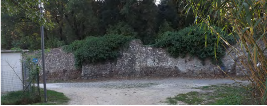
Foto n. 36 a – Il tratto di muro su cui probabilmente si apriva la terza porta
