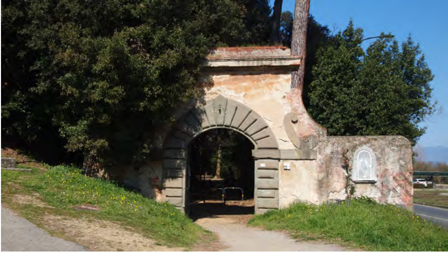
Foto n. 34 - La porta del Barco verso Poggio a Caiano e la Villa; alla sinistra inizia la via Ertona
