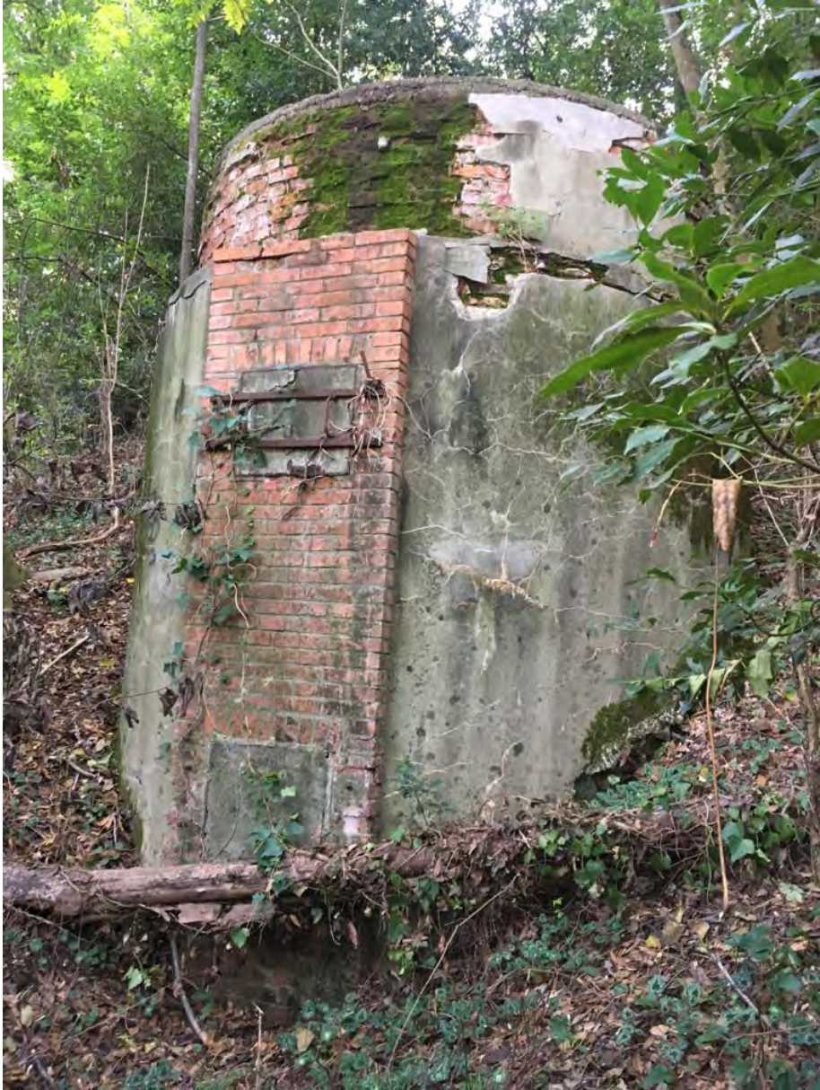
Foto n. 24 b - Silo, stato attuale
