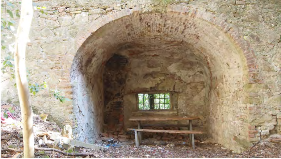
Foto n. 16 – Il piccolo ambiente coperto a volta all'interno del rudere del casino di appostamento dell'ucellare; rimangono le tracce di un camino e l'unica finestra originaria rimasta
