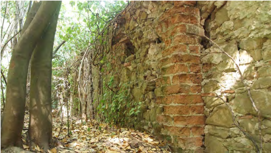
Foto n. 36 b – La stessa area vista dall'interno del Barco
